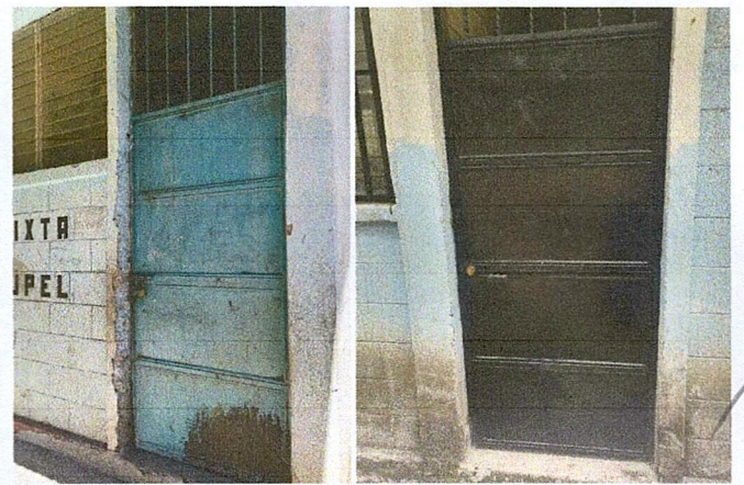
Foto 4: MEJORAMIENTO E INSTALACION DE PUERTAS
