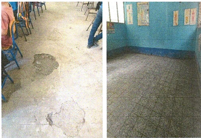
Foto 3: MEJORAMIENTO DE PISO E INSTALACION TIPO CERAMICO O GRANITO
